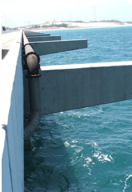
Figura 3.20 - Vista Parcial da Ponte de Acesso ao Pier, com a Tubulação do Emissário da Termelétrica
