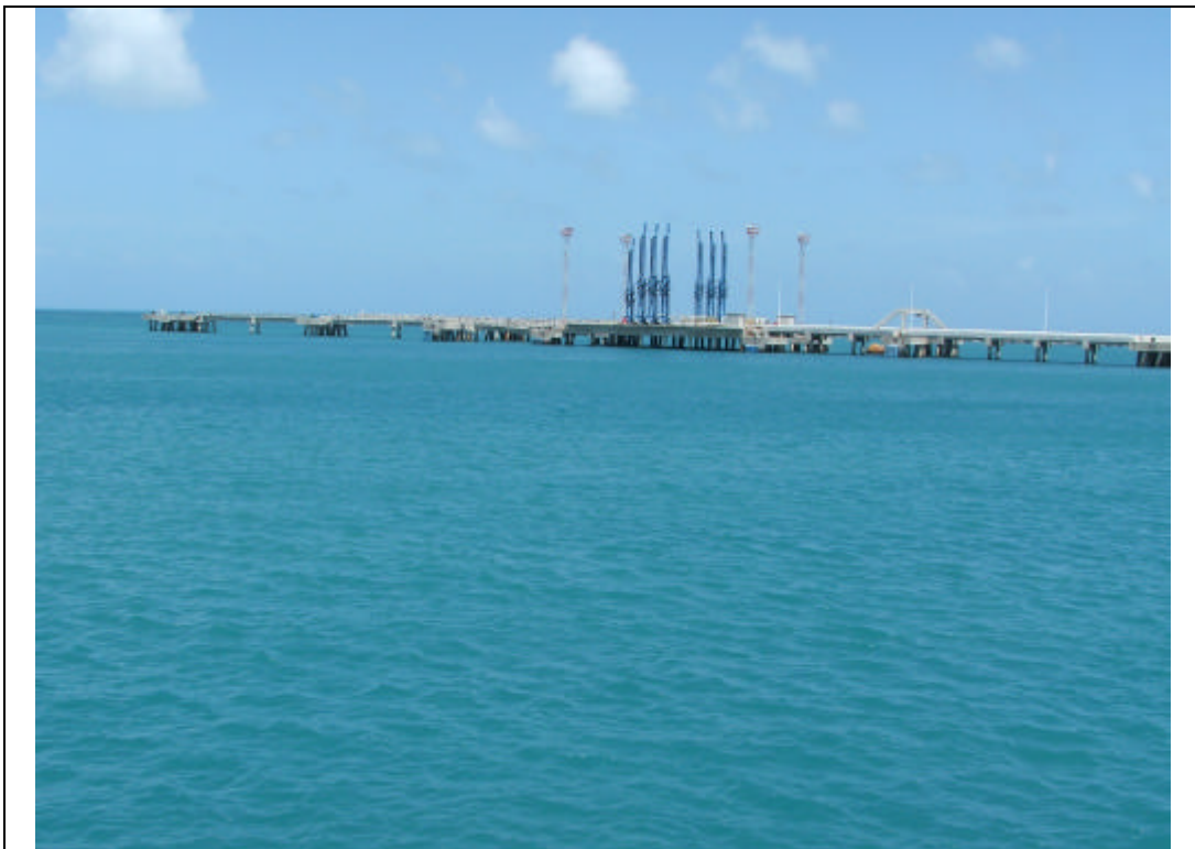
Foto 12 – Vista parcial dos piers do Terminal Portuário do Pecém.
