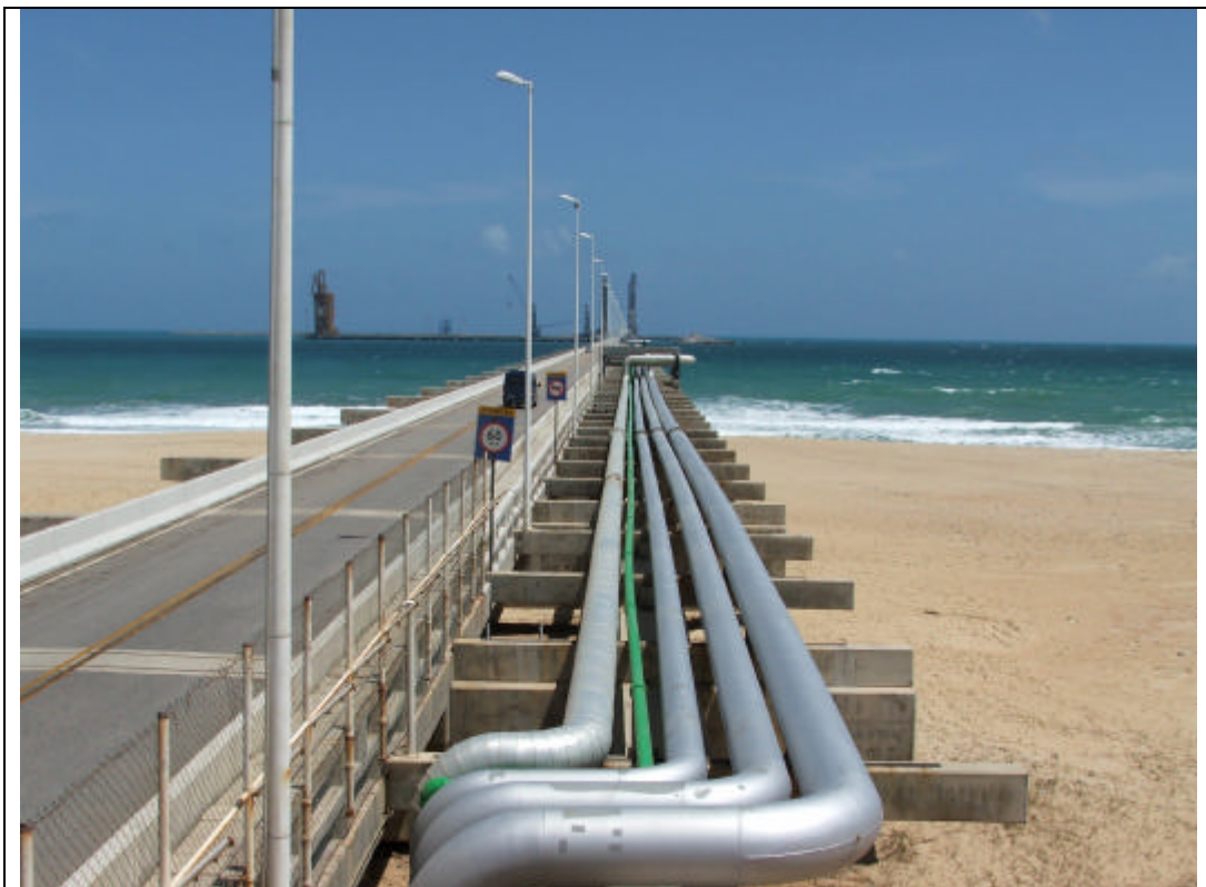
Foto 10 – Ponte de acesso aos piers do Terminal Portuário do Pecém.
