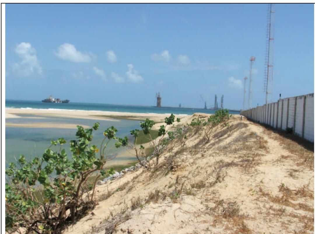
Foto 8 – Trecho onde as tubulações das adutoras de água salgada e de disposição do concentrado se desenvolvem margeando o pátio do Terminal Portuário do Pecém.
